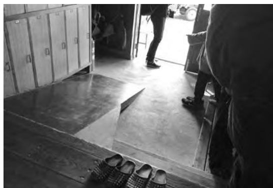
スロープの設置
